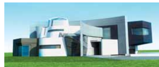
ELEWACJA POŁUDNIOWO-WSCHODNIA: z tej strony widać dokładnie futurystyczną bryłę poskręcaną w różnorodnych kierunkach
