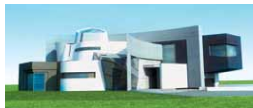
ELEWACJA POŁUDNIOWO-WSCHODNIA: z tej strony widać dokładnie futurystyczną bryłę poskręcaną w różnorodnych kierunkach
